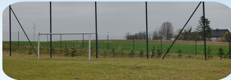
Zakup i zamontowanie piłkochwyków na boisku szkolnym w SP w Dużej Cerkwicy – 18 942 zł
