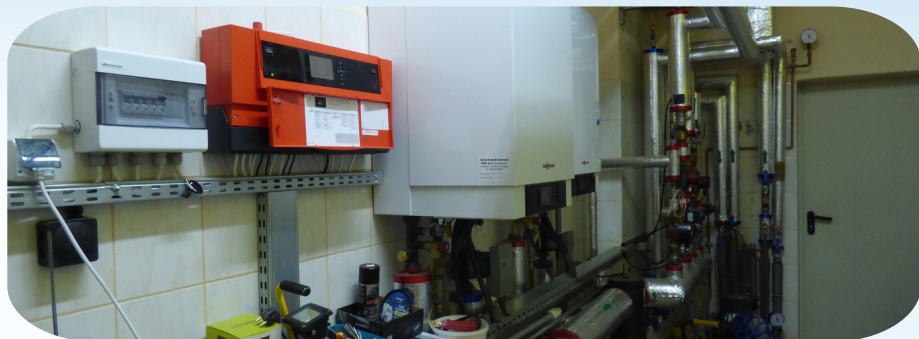
Modernizacja kotłowni i ogrzewania w SP w Dużej Cerkwicy – 158 170 zł
