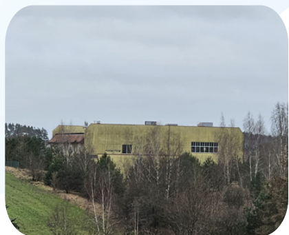
Remont dachu w ZSP Kamień Kr. ul. Witosa 12 – 143 616 zł
